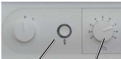
кнопка деблокирования (сброса) режима неисправности
