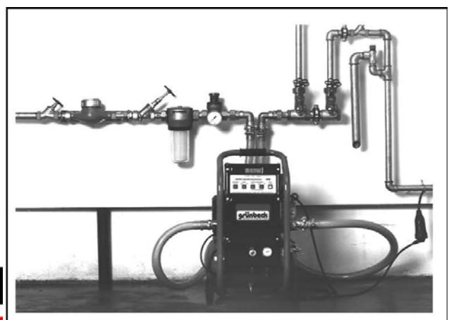
давление 8 бар, компрессор автоматически отключается. Далее нажать «Промывка вода + воздух».
