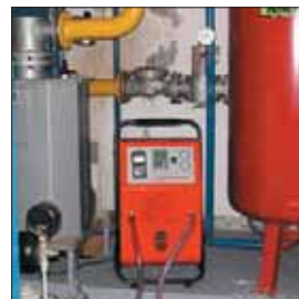
Удаление грязевых отложений из отопительных установок
